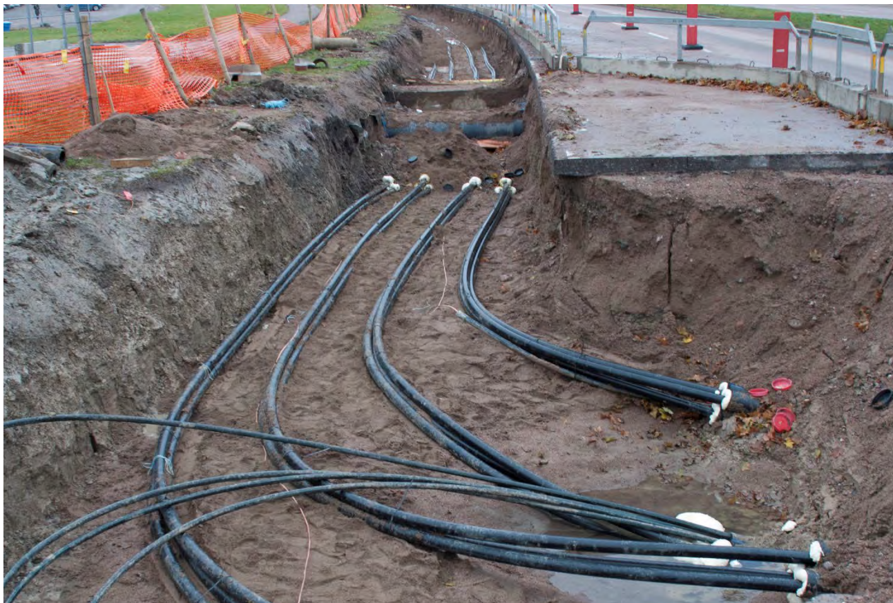
Figur 31. Foto kabelschakt med fyra parallella kabelförband enligt vad som planeras för kabelsträckor för aktuellt projekt.
