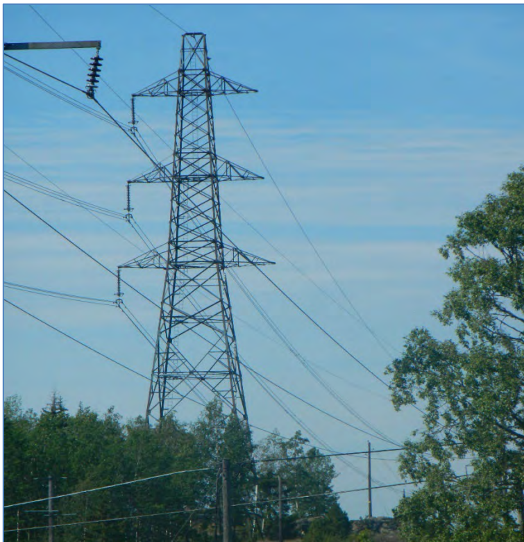
Figur 22. Foto på Svenska kraftnäts befintlig stolpar på sträckan Lissma-Ekudden där planerade ledningar hängs upp i lediga reglar (på höger sida av stolparna i bilden).
