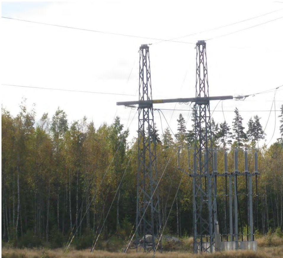
Figur 18. Exempel på utförande av kabelstolpe (vid övergång mellan luftledning och markkabel).
