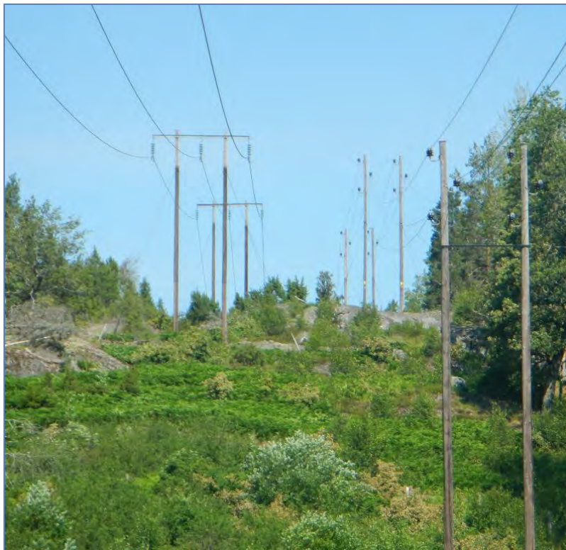
Figur 25. Befintlig 70 kV- (vänster) och 20 kV ledningar (höger). 20 kV ledningarna planeras att raseras och skogsgatan nyttjas för anläggning av nya 130 kV ledningar. När de nya ledningarna är tagna i drift kan befintlig 70 kV ledning tas bort.
