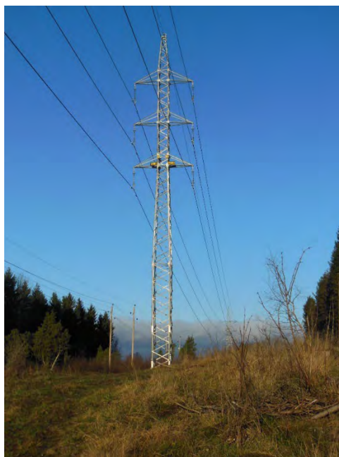
Figur 17. Skiss enbent stålstolpe med vertikalt placerade faslinor, samt foto enbent stålstolpe.
