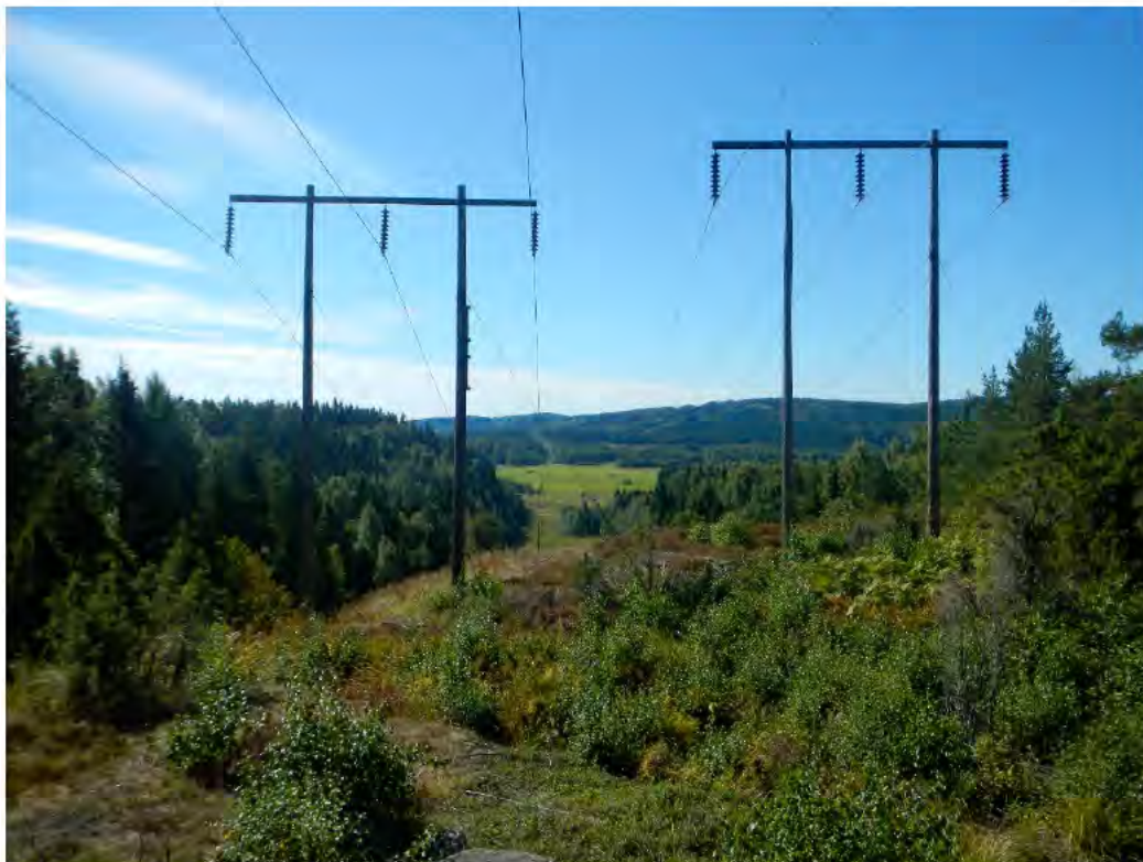
Figur 20. Foto på två parallella 130 kV kraftledningar uppförda i träportalstolpar. Observera att stolparna på bilden saknar topplinor.
